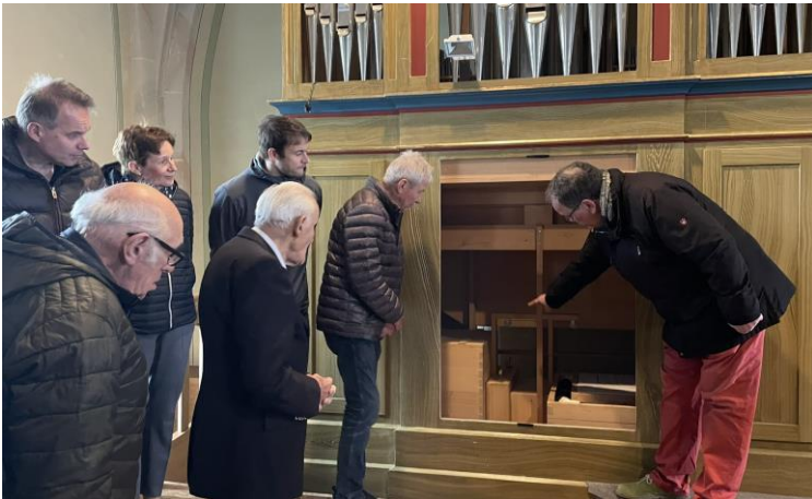
Blick ins Innere der Balganlage
